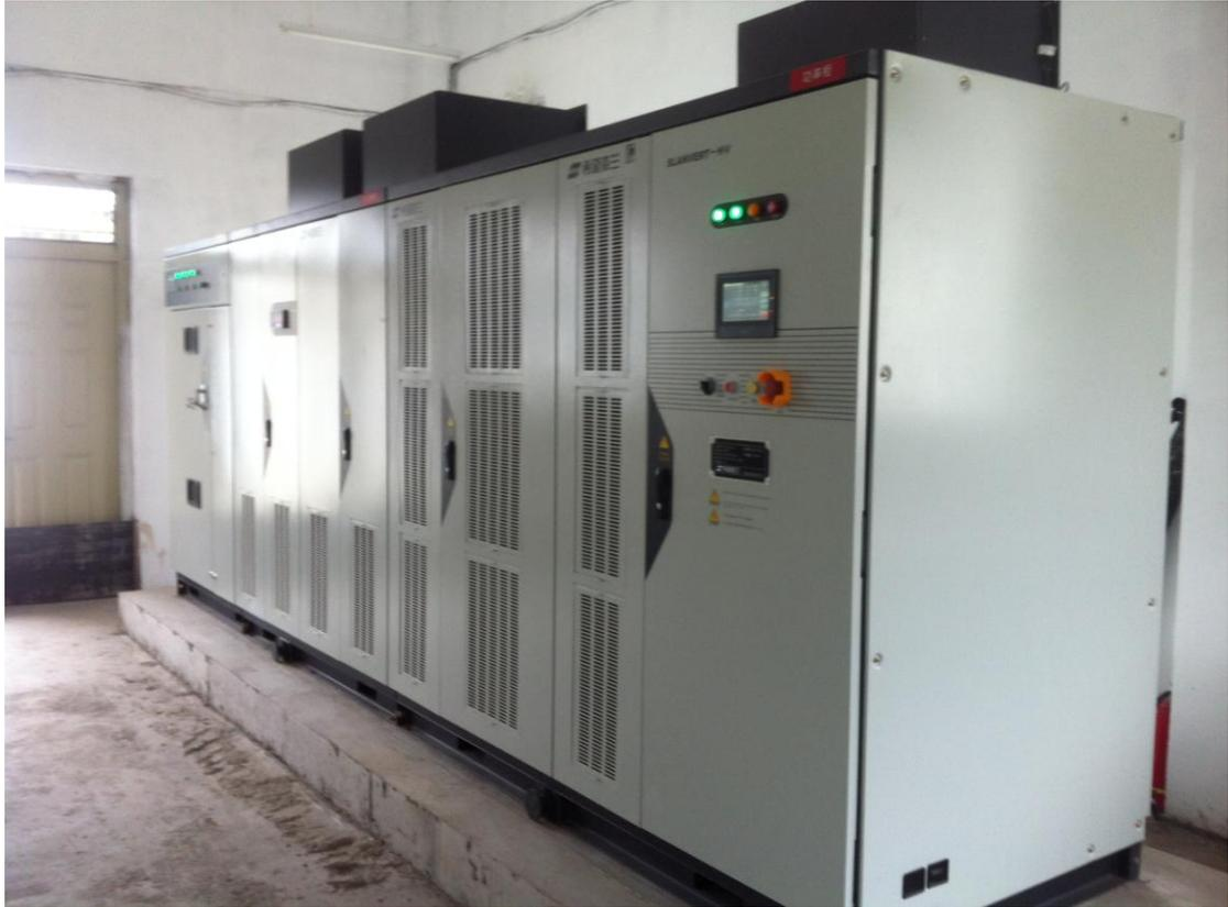
图 4：森兰 SBH 系列高压变频器
